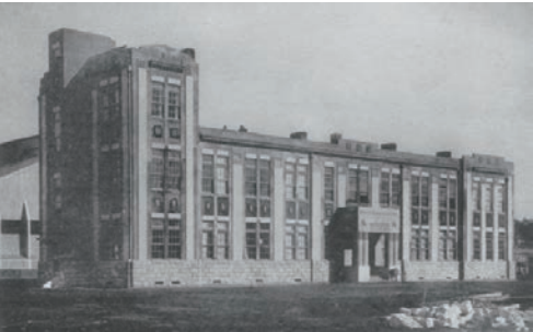
飛行場敷地内に建てられた施設建物の一部 立川飛行第五大隊本部
