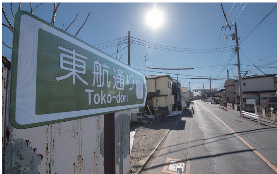
東航通り（北端から南をのぞむ）
