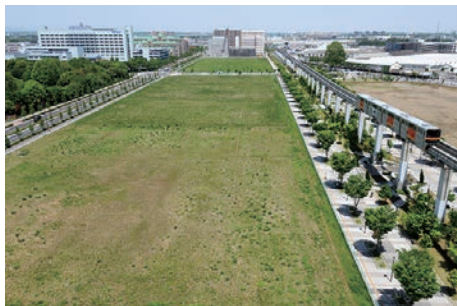
まだIKEAができる前 2008年に撮影 モノレールが走っているところに大格納庫があった
