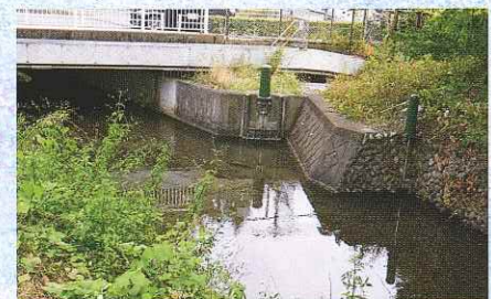
玉川上水にかかる松中橋。右側が柴崎分水の取り入れ口、左は砂川分水。
