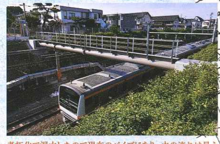
老朽化で漏水したので現在のパイプになり、水の流れは見えなくなった。
