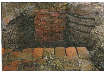
初代めがね橋の橋脚部分。イギリス積みといわれる積み方で、長手だけの段と小口だけの段が交互に重なっている。
