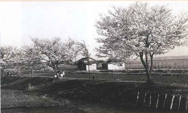
16 昭和16年4月 根川堤より日野橋を見る ☆
