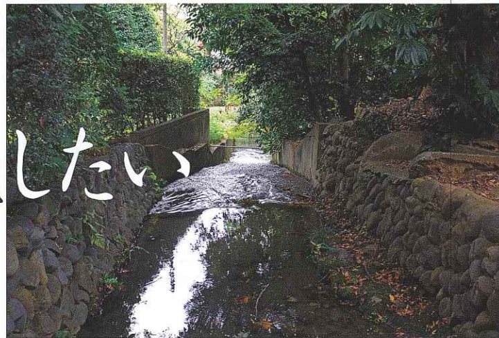
玉川上水からの取水口。 右側が柴崎分水、左が砂川分水。
