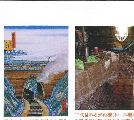
二代目のめがね橋（レール橋）から三代目に架け替える工事中に土の中からあらわされた一代目めがね橋の橋脚部分（昭和11年以前に人が渡っていた橋）
