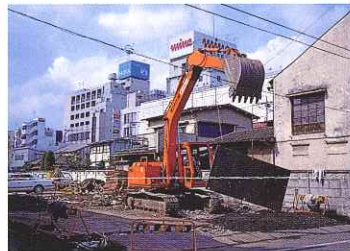
南口駅前の工事が進む (1989年3月22日)
