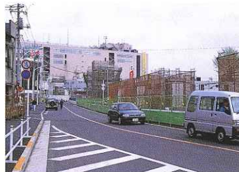
1997年4月 モノレールの橋脚
