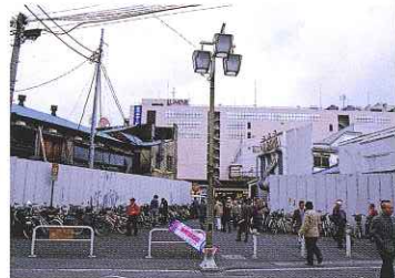
1999年4月5日 古い建物の解体
