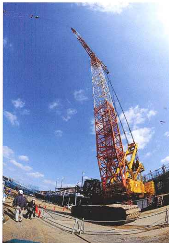
当時都内に1台しか稼働していなかった500tのクレーン車
