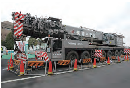
新しい橋げたを吊り上げて架けるために準備されたクレーン車 250t用 (2010年2月22日撮影)
