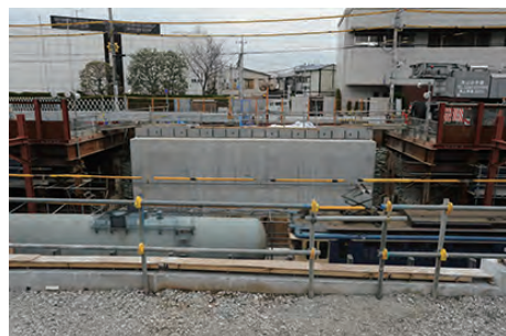
この夜から夜ごと橋げたを渡す工事が行われた (2010年2月22日撮影)
