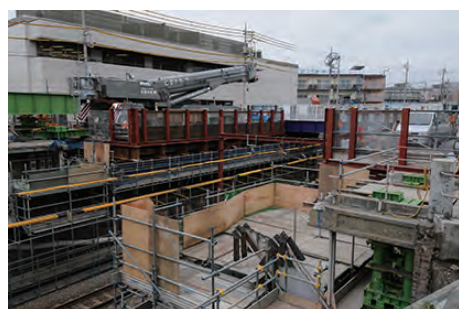
橋の取り外しに使われたクレーン車 (2009年3月8日撮影)
