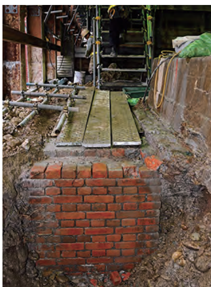
掘削すると、土台が当時のままに現れる。
