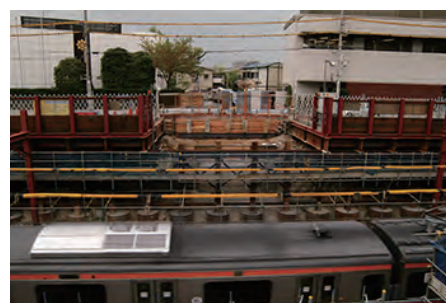
線路の西側の工事現場で煉瓦の土台が見つかった。
