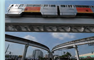
モノレール本線からモノレール基地への 引き込み線を望む
