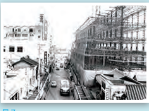
昭和40年12月22日 西側から駅方向を見る 建設中の第一デパート
