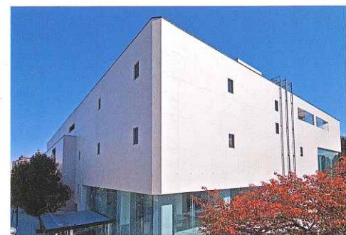
たましんRISURUホール
