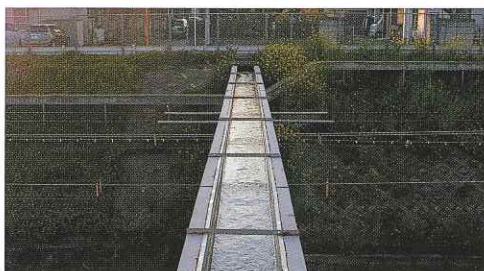
中央線の上を通る柴崎分水(ここが昔の山中陸橋)
