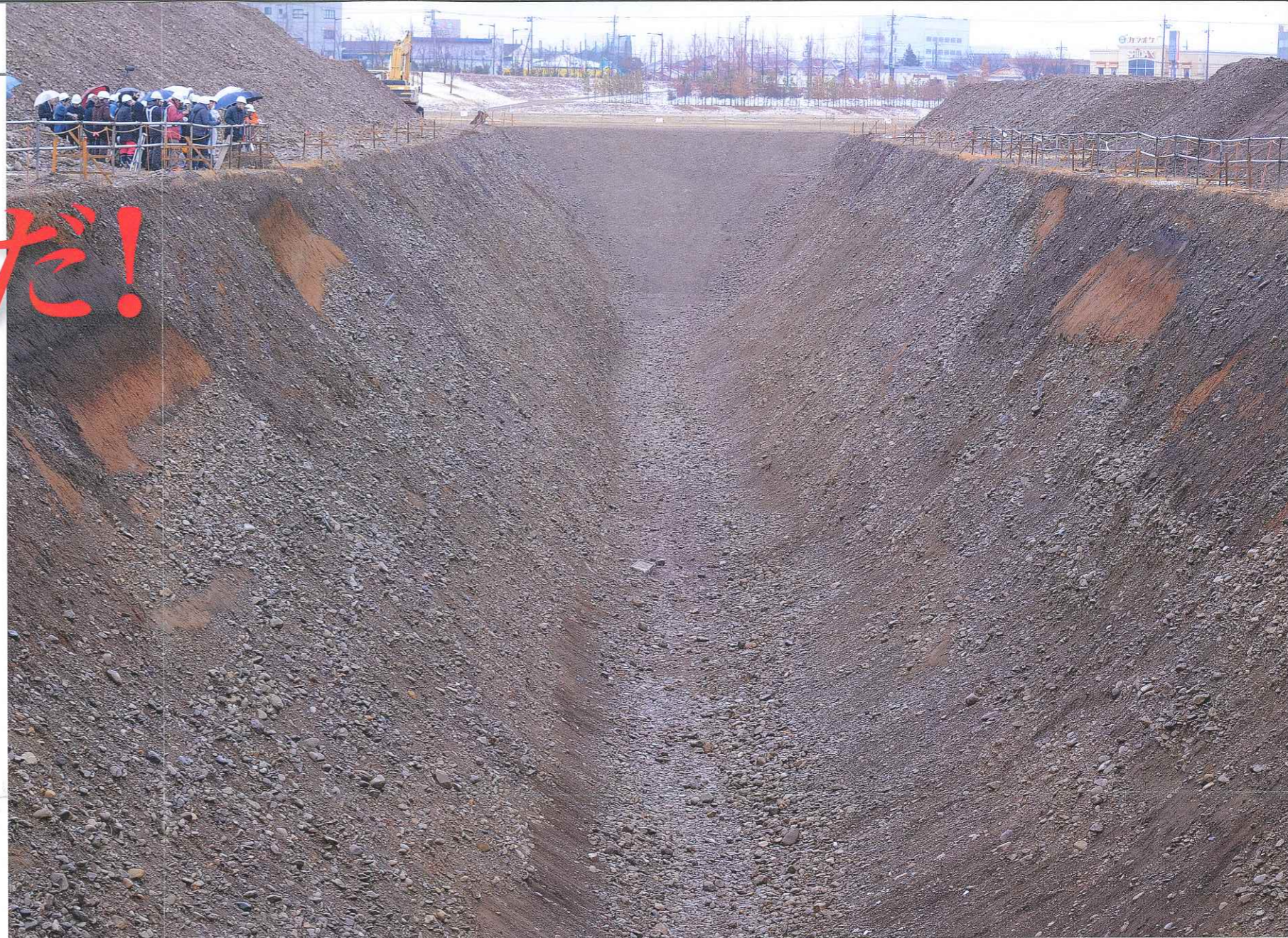
真如苑プロジェクト用地に掘られた「複トレンチ」 左右両面に茶色く見えているのは立川ローム層と呼ばれる部分
