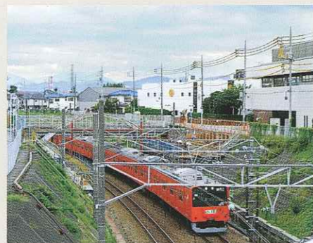
レール橋の二代目めがね橋
