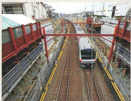
橋脚が完成(仮歩道から撮影)
