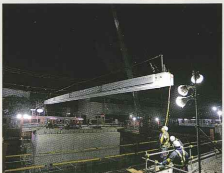
橋桁1本目をかけるところ(1日目)
