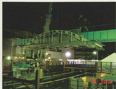
レール橋の撤去
