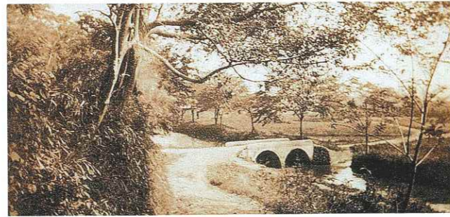
番場坂下の橋(昭和12年)
