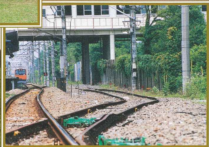
JR西立川駅に残る陸軍航空廠立川支廠の塀
